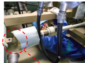
配管支持構造物の点検作業 (配管との接合部の保温材を外して点検)
